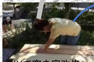
DIYで空き家改修
